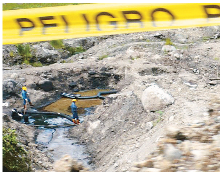
Reparaturarbeiten an Lecks im ecuadorianischen Ölleitungssystem Sistema de Oleoducto Transecuatoriano (SOTE).
