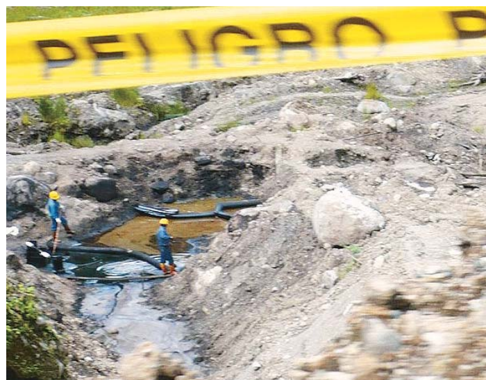
Reparación de una fuga en el Sistema de Oleoducto Transecuatoriano (SOTE).
